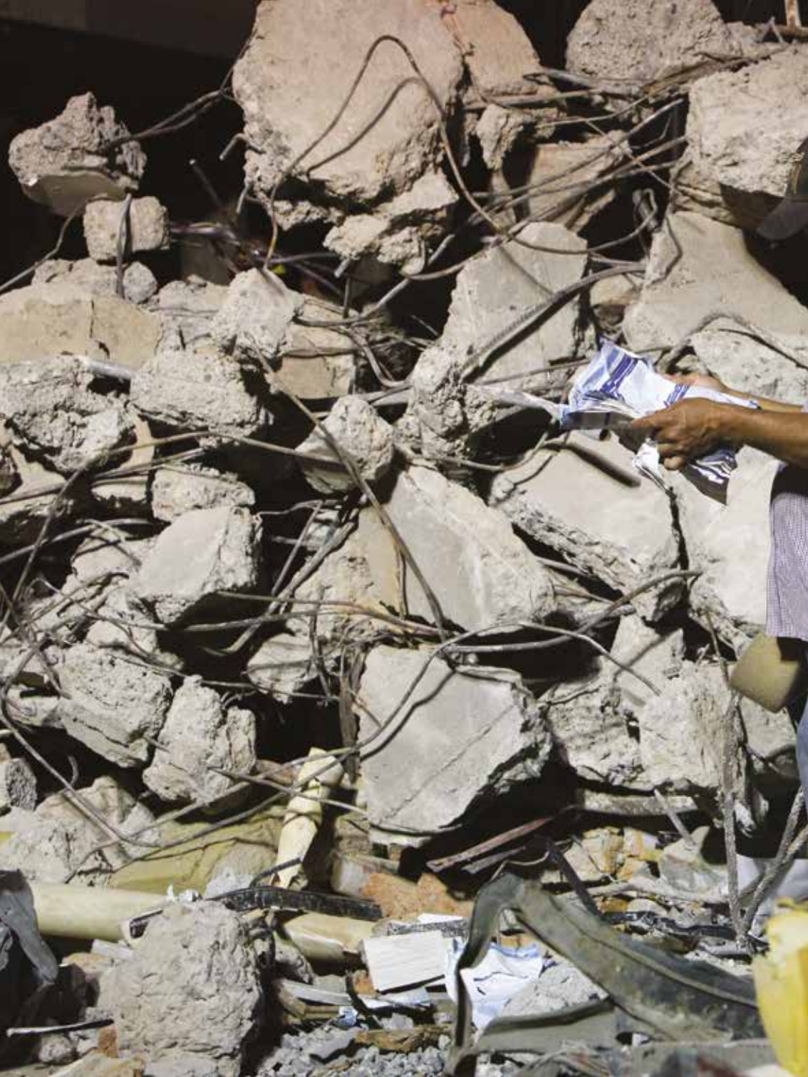
Los habitantes de Manta colaboraron en la remoción de escombros.
