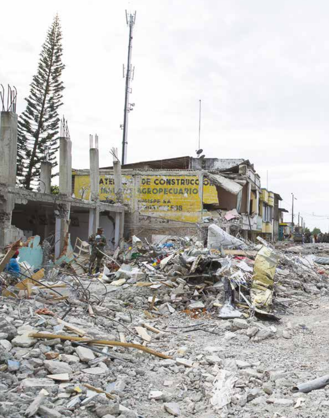
El sismo destruyó gran parte de la ciudad, edificios fueron reducidos a escombros.
